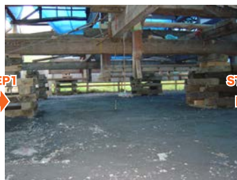
碎石敷き完了
