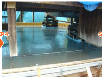
土間コンクリート打設
