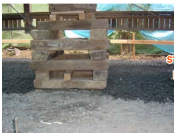
基礎工事碎石敷き
