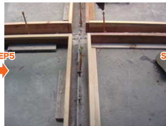
型枠組立状況
