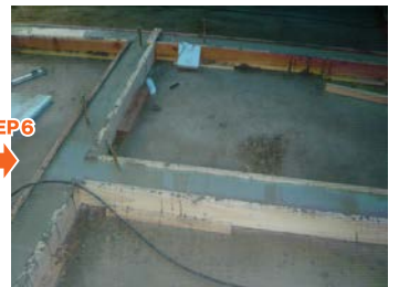
立上がり打設完了
